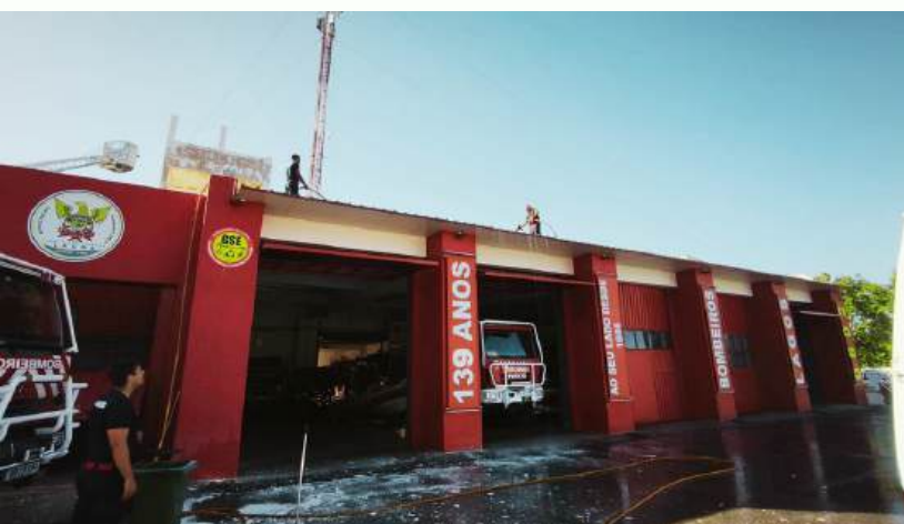
MANUTENÇÃO DAS INSTALAÇÕES
